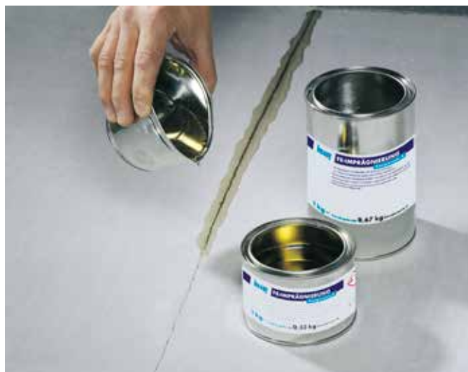
Grafika 54: Wypełnianie pęknięć żywicą epoksydową
