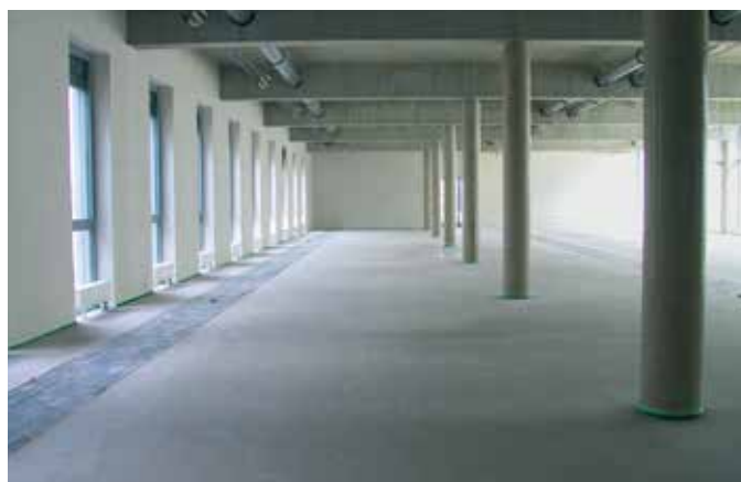
Grafika 16: Gotowa powierzchnia podkładu anhydrytowego w konstrukcji podłogi podniesionej z kanałem rewizyjnym
