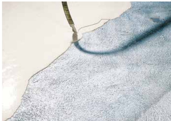
Grafika 57: Maszynowe wykonanie Knauf N 410
