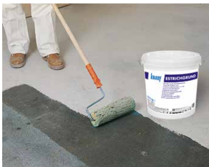
Grafika 55: Nanoszenie środka gruntującego Knauf Estrichgrund
