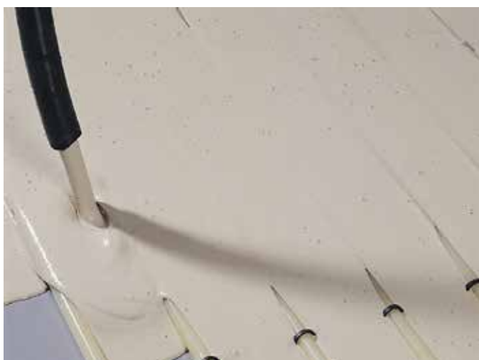
Grafika 10: Aplikacja anhydrytowego podkładu grzewczego
