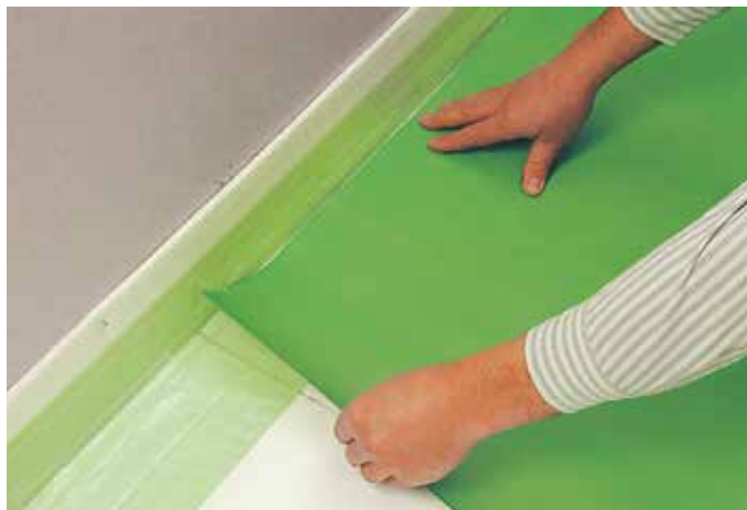
Grafika 8: Układanie warstwy papieru parafinowego Knauf
