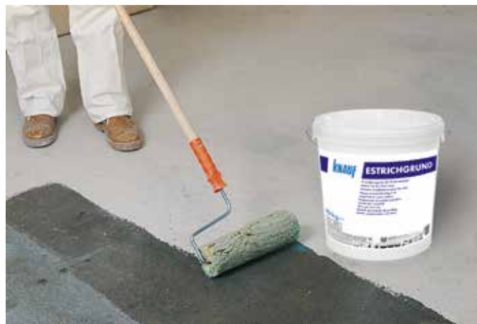
Grafika 4: Nanoszenie Knauf Estrichgrund
