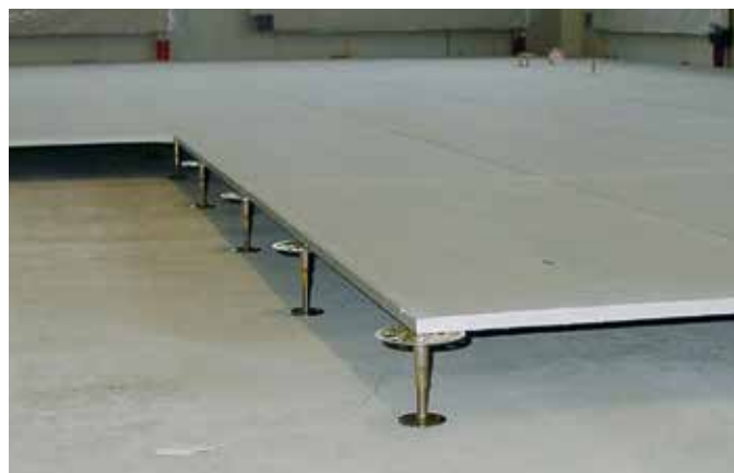
Grafika 14: Układanie stopek i elementów szalunkowych
