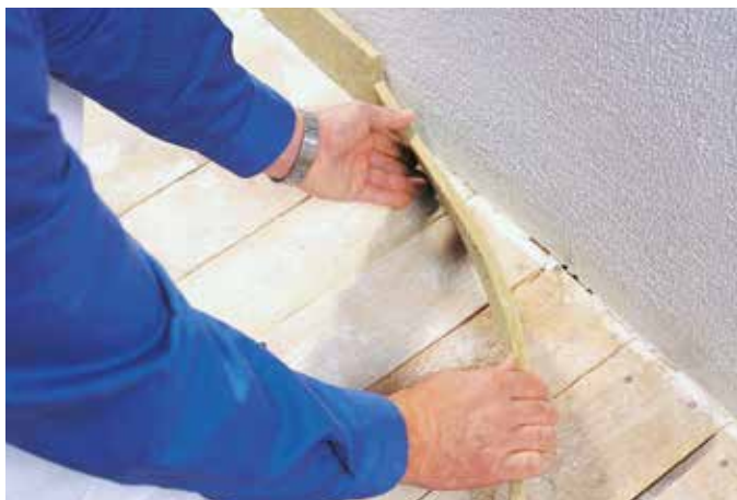
Grafika 23: Układanie brzegowej taśmy przyściennej z wełny mineralnej Knauf, jeżeli istnieją wymogi dotyczące ochrony przeciwpożarowej
