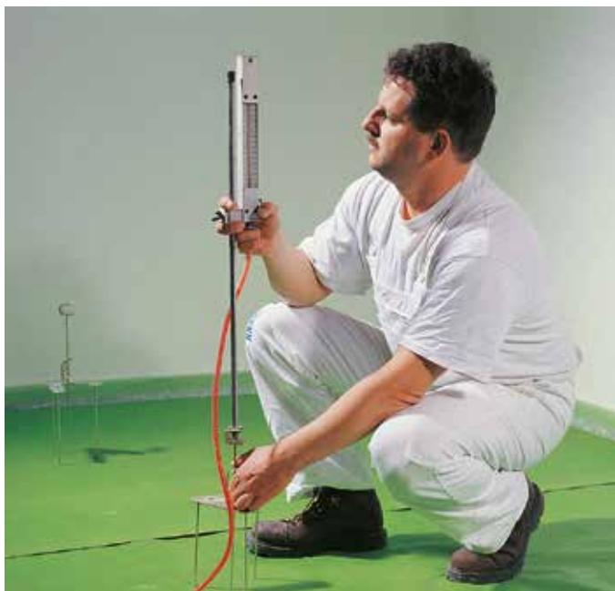
Grafika 40: Ustalanie poziomu podkładu za pomocą niwelatora PFT
