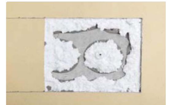
Metoda klejenia obwodowo punktowa. Minimum 40% kleju na powierzchni płyty izolacyjnej
