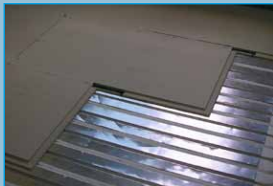
Lekka konstrukcja podłogi
