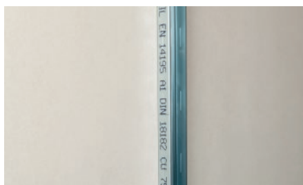
1. Profil zamontować na sąsiednim elemencie budowlanym
