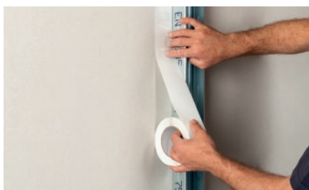
2. Trenn-Fix rzykleić obok profilu
